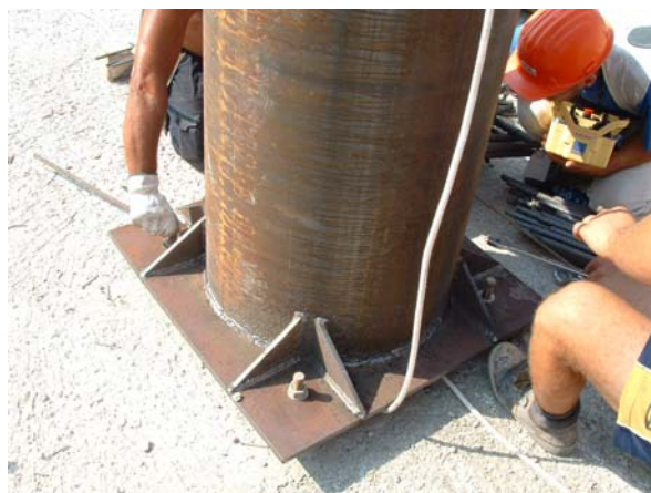
Figura 6. Fissaggio PMC ai tirafondi
