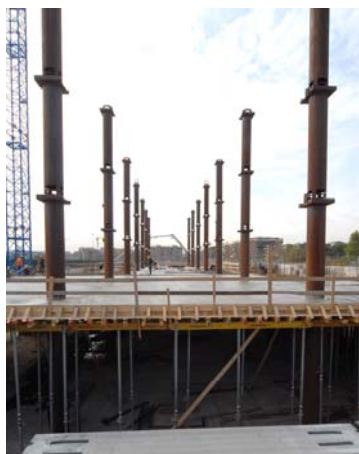
Figura 12. Getto unitario di pilastri, travi e solai Poker
