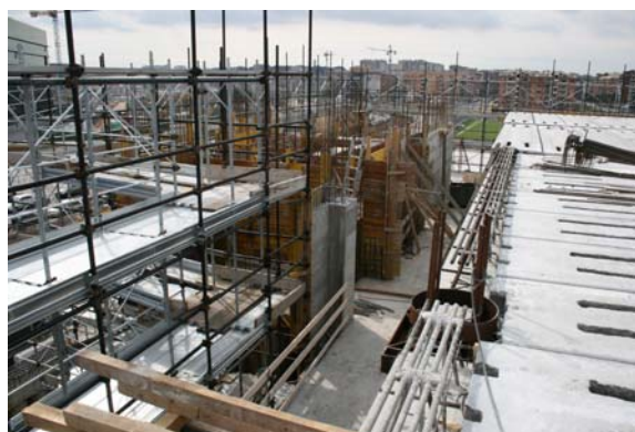
Figura 7. Posa di travi PREM e solai Poker
