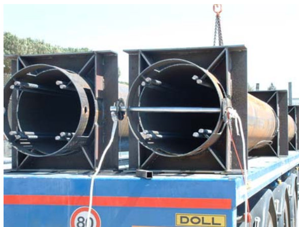
Figura 5. Aggancio con spinotto in fase di montaggio
